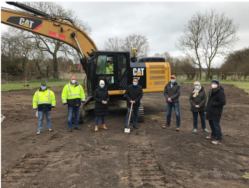
Spatenstich auf dem Wildkoppelweg in Cismar (Foto ©IMMAC)
